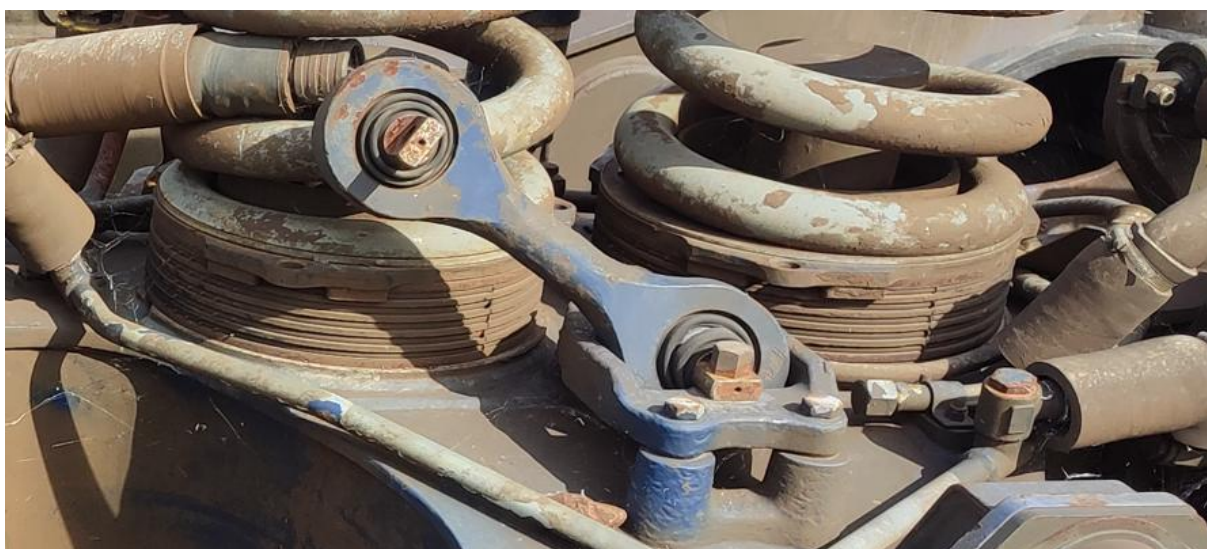
Figure 81 – Bielle de liaison entre le châssis de bogie et la barre antiroulis. On distingue derrière les deux ressorts de la suspension secondaire.
