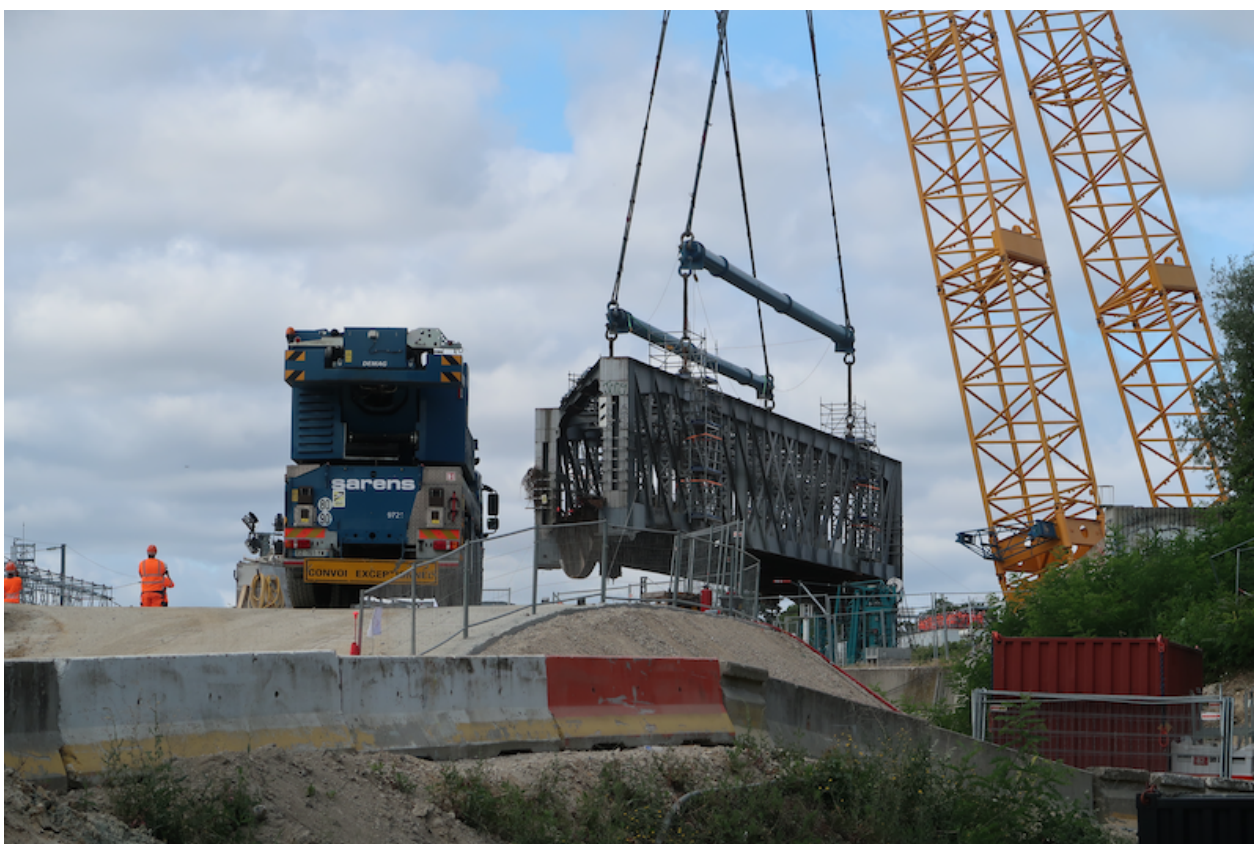
11h 10 : avec une rotation sur sa base circulaire la grue oriente l'ouvrage métallique vers l'avenue où l'attendent les chariots de transport.
