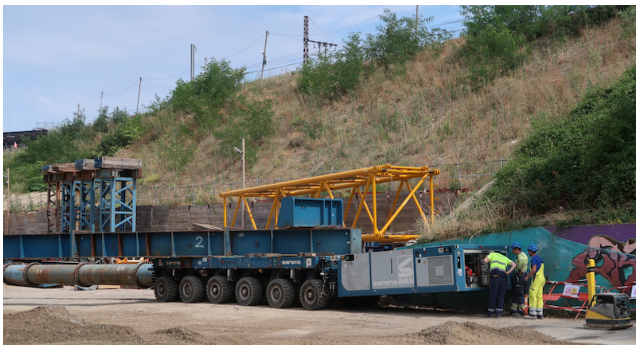
Chariots de transport motorisés : les agents chargés du déplacement testent l'équipement avec ici le démarrage du moteur Diesel. Ce cliché a été pris ce 18 juillet vers 16h00 quelques heures avant le « grutage » de « Gallardon ».
