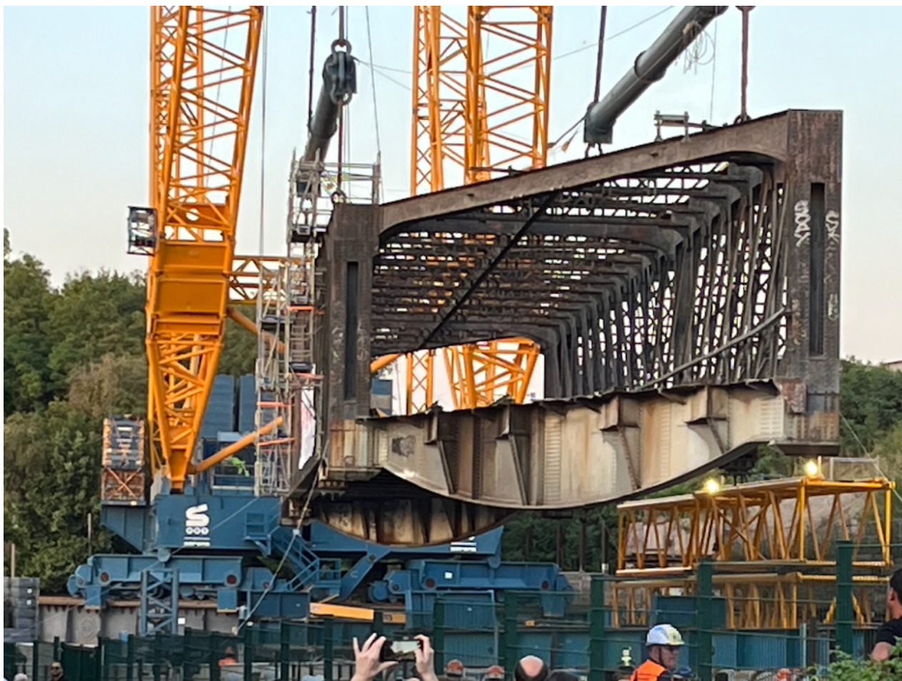
21h25 : le pont de 480 tonnes « Gallardon » se pose doucement sur ses chariots de transport qui le conduiront 100 m plus loin sur la zone de démantèlement.
