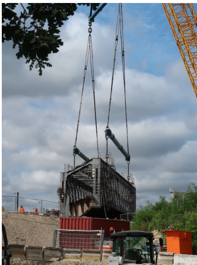
11h01 : l'ouvrage de la ligne B a décollé de ses bases. « Little Celeste » le lève en douceur avec d'innombrables précautions.
