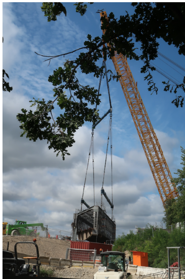
11h03 : l'ascension du pont métallique est quasi imperceptible.
