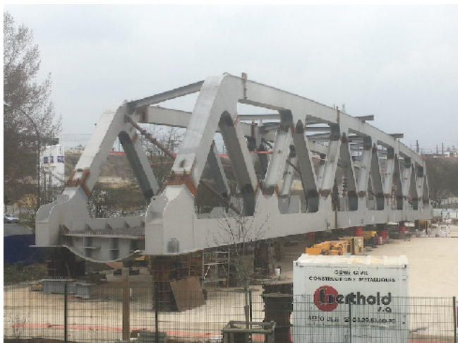
Figure 9 : assemblage des poutres et les finitions du futur pont métallique « Chartres ». l'image ci-contre donne l'allure générale de l'ouvrage. Noter que les soudeurs pénètrent à l'intérieur des membrures pour travailler. Clichés Alain Jeunesse avril 2022.
