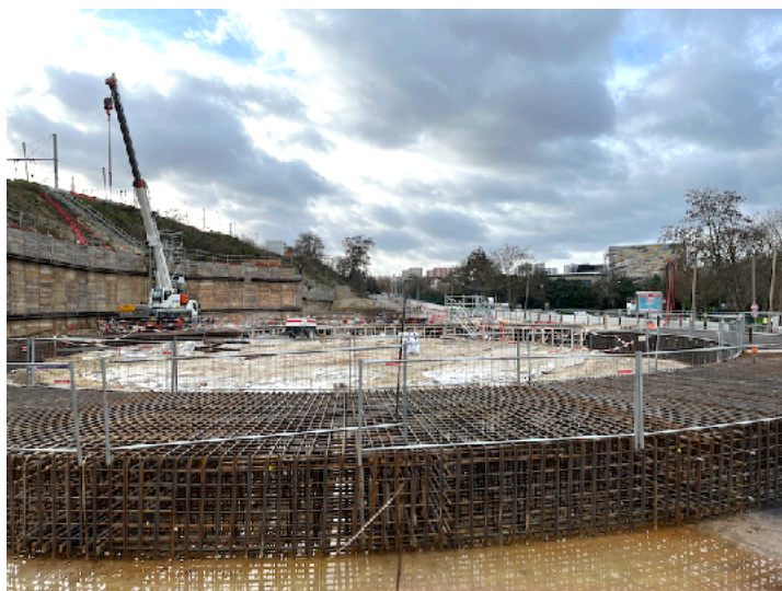
Figure 13 : le ferrailage de la base circulaire en béton armé destinée à supporter « Little Celeste ». Sur la gauche nous pouvons observer le mur de soutènement et les supports caténaire de la ligne stratégique.
