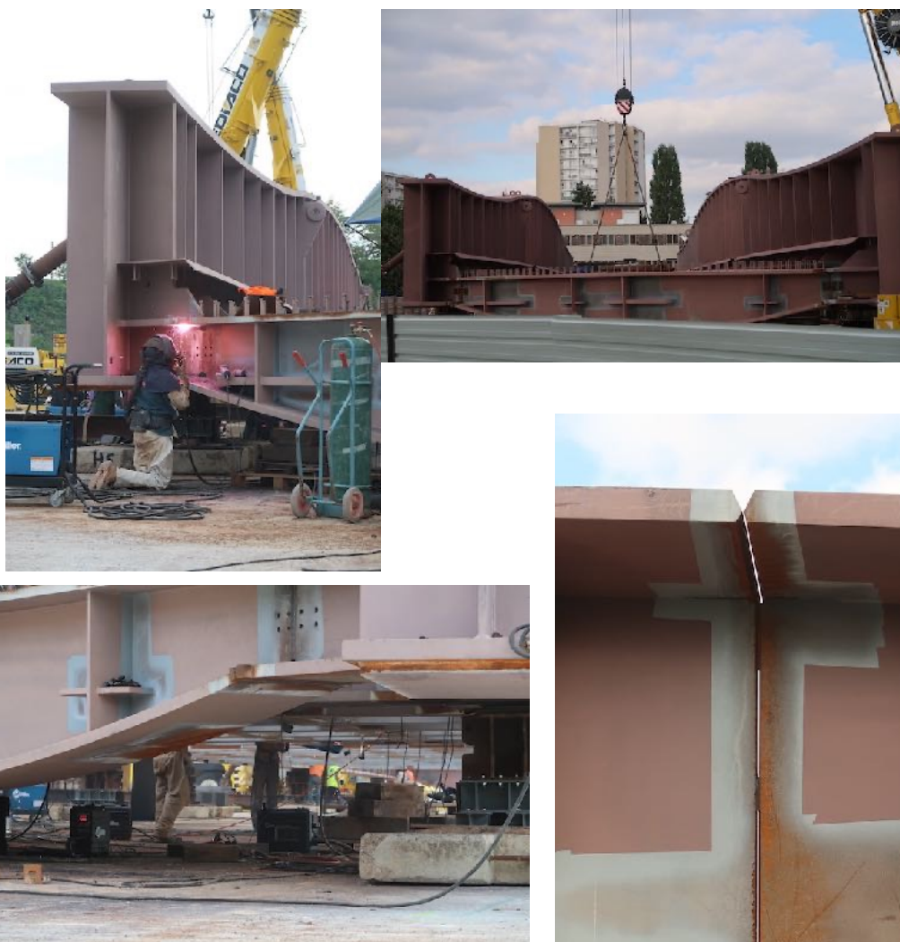
Figure 6 : diverses vues de la construction du nouveau Gallardon. A remarquer l'épaisseur des poutres d'acier et le travail des soudeurs. clichés Alain Jeunesse septembre 2021.
