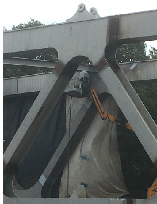
Figure 9 : assemblage des poutres et les finitions du futur pont métallique « Chartres ». l'image ci-contre donne l'allure générale de l'ouvrage. Noter que les soudeurs pénètrent à l'intérieur des membrures pour travailler. Clichés Alain Jeunesse avril 2022.
