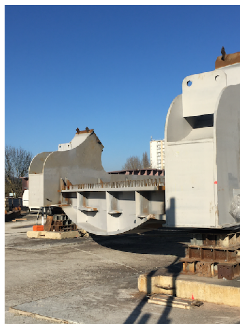
Figure 8 : quelques vues de la construction de Chartres. Cet ouvrage imposant est destiné à supporter les voie de la ligne B. Clichés Alain Jeunesse décembre 2021 et Janvier 2022.
