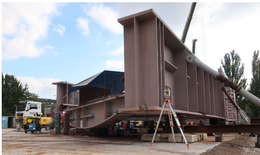
Figure 5 : pont Gallardon en cours de construction (Cliché Alain Jeunesse septembre 2021)
