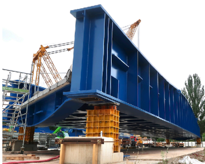
figure 7 : Gallardon prêt à être posé pour supporter les voies de la ligne C. A titre d'information cet ouvrage à une superficie globale en peinture de 7150 m 2 . Cliché Alain Jeunesse Juillet 2023
