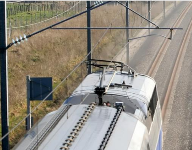
Figure 15 : Vue de la toiture de motrice arrière (M1) illustrant la mise en place de capots à la place du pantographe 1500 V
