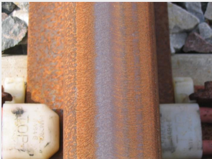
Figure 46 : photographie montrant l'aspect du rail sur le domaine d'essais : nous distinguons parfaitement les traces du meulage.
