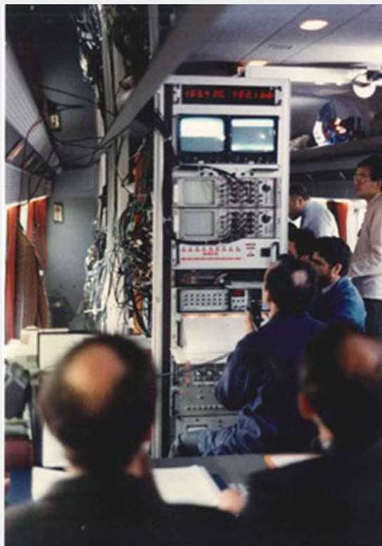
Figure 14 : Au premier plan la chaîne de mesure des paramètres électriques : captage et motorisation Collection Claude MARO
