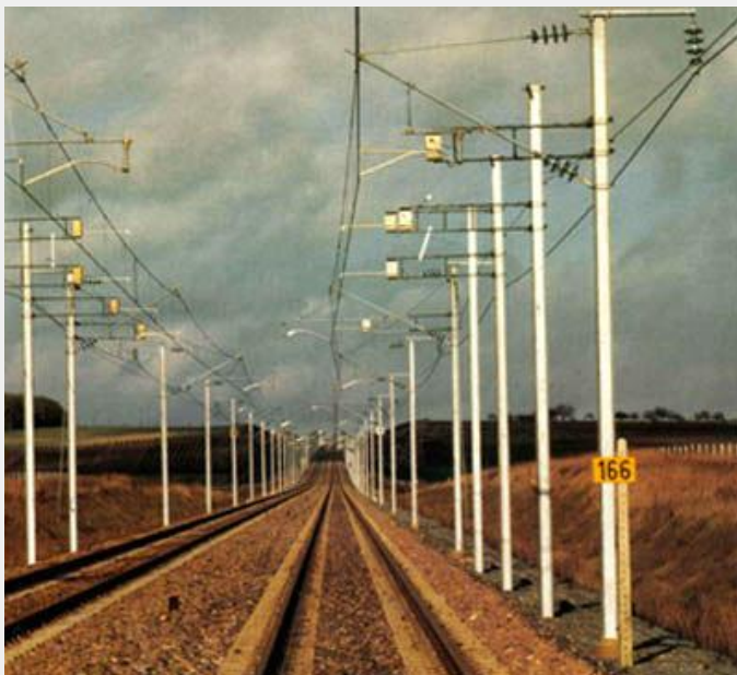
Figure 6 : PK 166, instrumentation de mesure du soulèvement de la caténaire.
