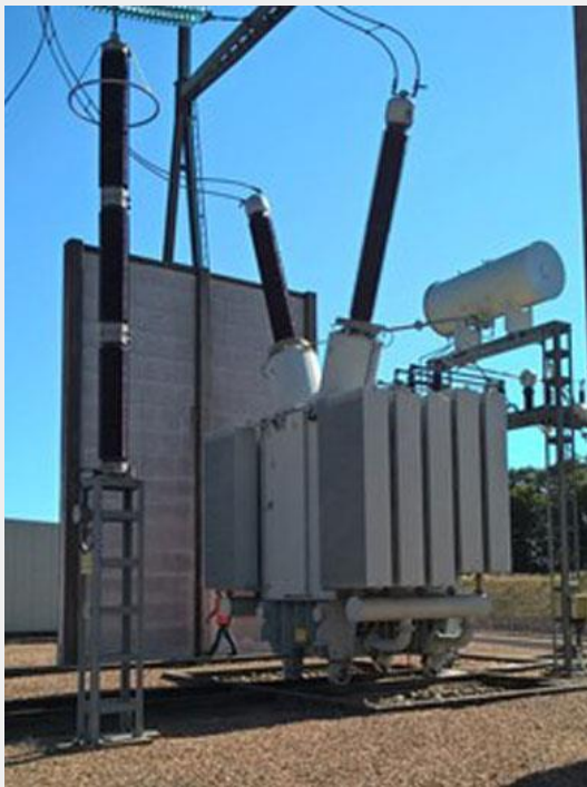
Figure 4 : Sous-station de La Picocherie Schéma de principe et transformateur 400 kV/ 27,5kV/ 27,5 kV Document SNCF Réseau
